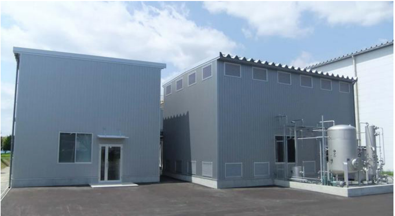
写真3 朝日印刷株式会社富山工場内に設置された検証プラント（資料提供：アルハイテック株式会社）
