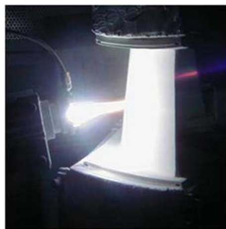
(b) 実翼へのTBC施工状況
