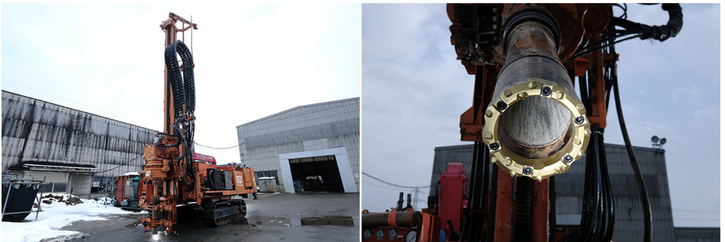
写真2 （左）高速掘削が可能なソニックドリル（右）そのビット
