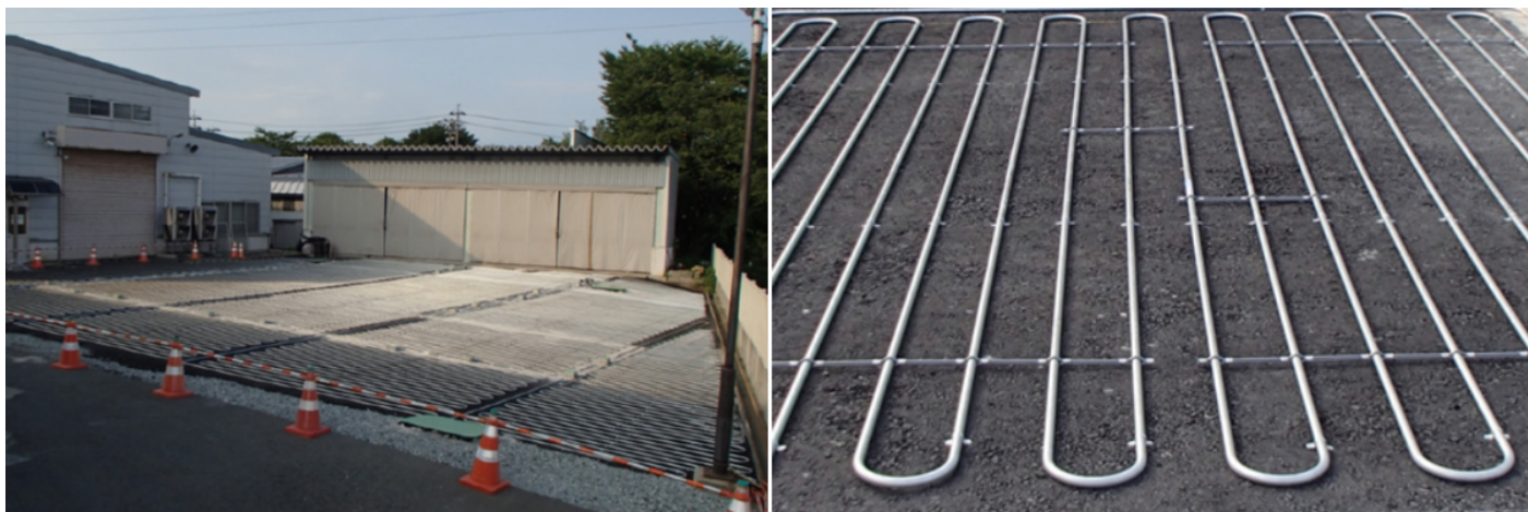
写真4 駐車場への伝熱管敷設状況（写真提供：日本地下水開発）
