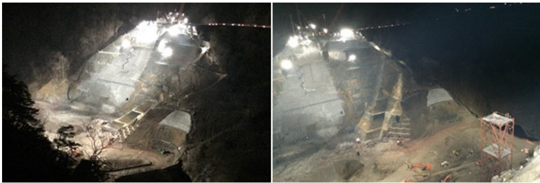
写真10 ハッ場ダム工事現場での利用（写真提供：四国計測工業）
