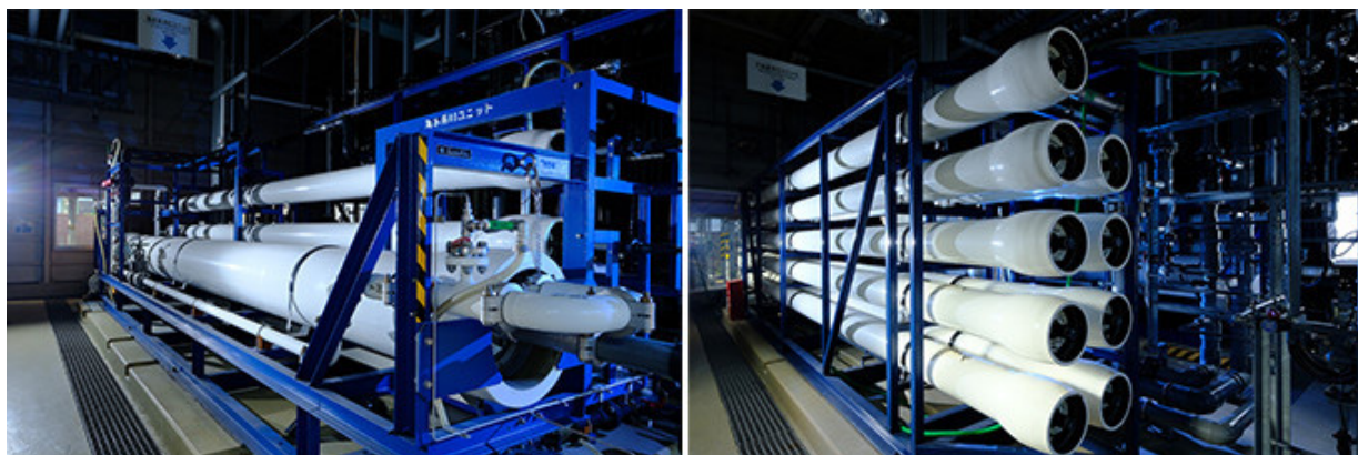
写真4 「ウォータープラザ北九州」に設置された海水RO膜(左)と、下水RO膜(右)
