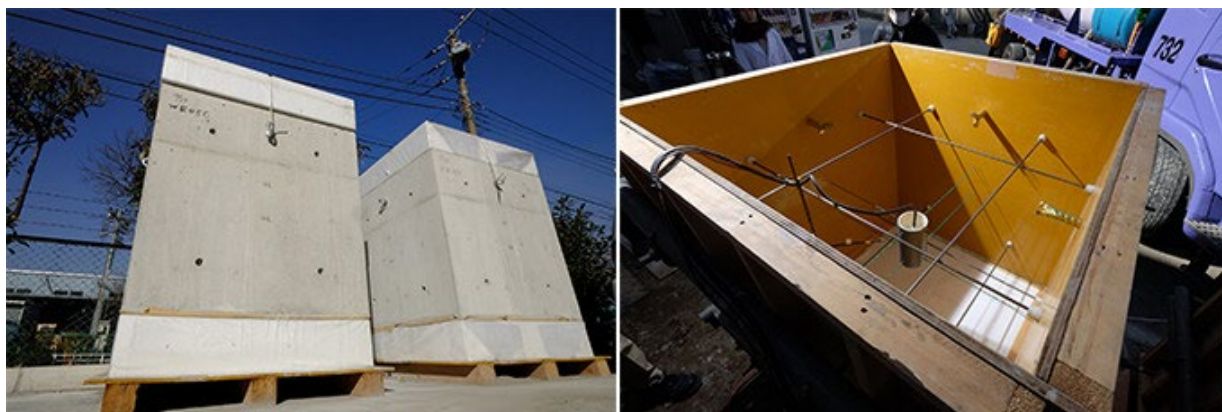
写真7 実証試験で作成した試験体（左）、1m角の試験体の型枠（右）。中には温度計とひずみ計もあり、その状態の変化を細かく計測していく
