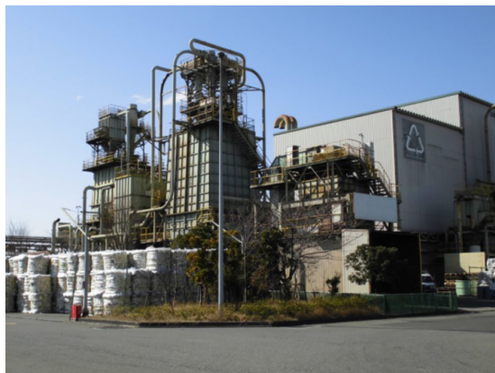
廃プラスチックを粒状化する工場 (提供:JFEスチール株式会社)
