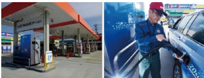
既存ガソリンスタンドに併設された 神の倉水素ステーションと(左)、その充填風景(右)
