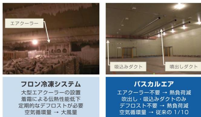
図7 従来の低温冷蔵倉庫(左)と「パスカルエア」を採用した冷蔵庫(右:入庫前)
