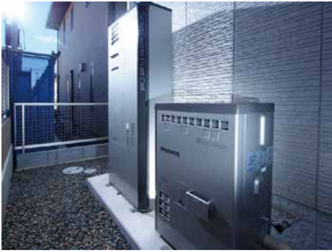
神戸市の住宅に設置された「エネファーム type S」、手前右側が発電部で、奥の背の高いユニットが貯湯部
