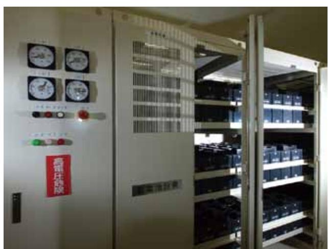
実証プラント内に設置された太陽電池（直流）連携コンバータ（左側）と蓄電池（右側・直流）
