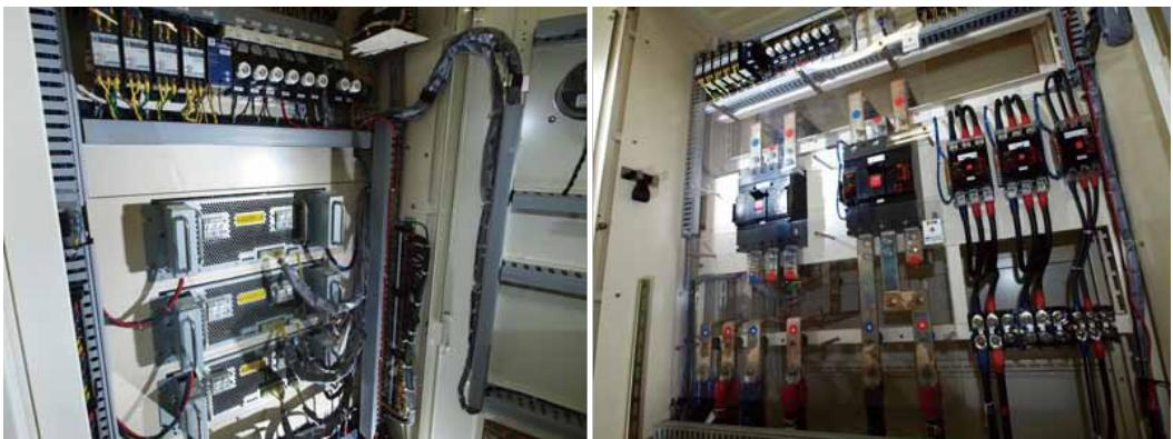
実証プラントの DC (直流) /DC コンバータ (左) と、直流分電盤 (右)
