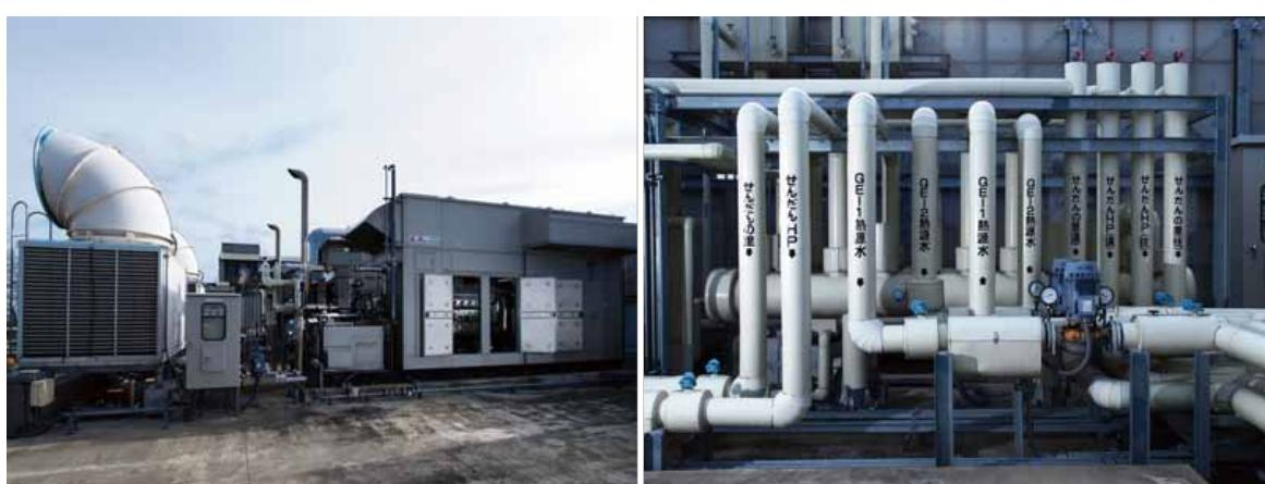
実証プラントのガスエンジン発電機（左）を利用したコ・ジェネレーションシステム、電力と温水（右）を実証研究エリアの施設に送る
