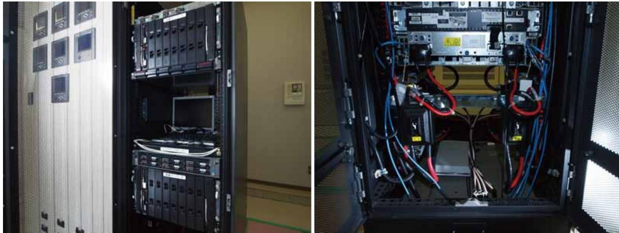
実証プラントコントロールルーム内で稼働する直流電源用サーバ（実証時のインテル製とは異なります）
