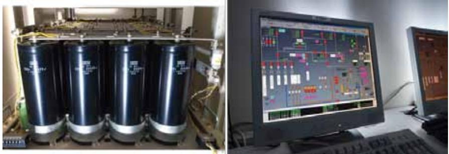
実証エリアの施設別に品質別の電力を送る分電盤（上左）、電力線（上右）、瞬時の停電や電圧低下を補うコンデンサ（下左）監視モニター（下右）
