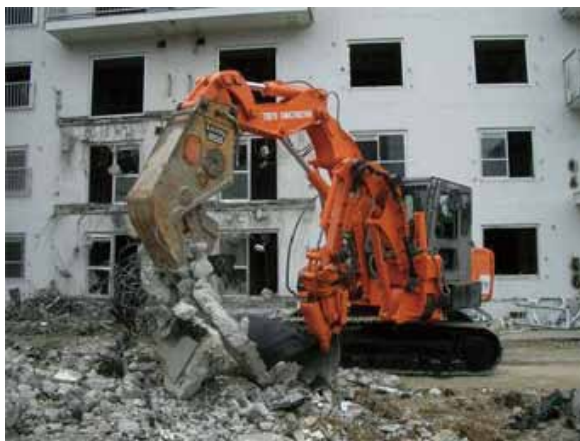
実際の解体現場で作業する試作機
