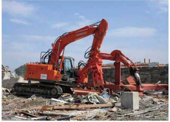
複雑に絡み合う建屋構造物、基礎材などの鉄スクラップを細かく切断、分別して移送。(南三陸町)
