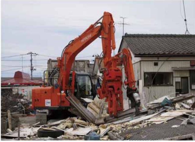
津波で押し流され市街地の路地を塞いでいたコンテナを、その場で解体・分別して移送。(石巻市)
