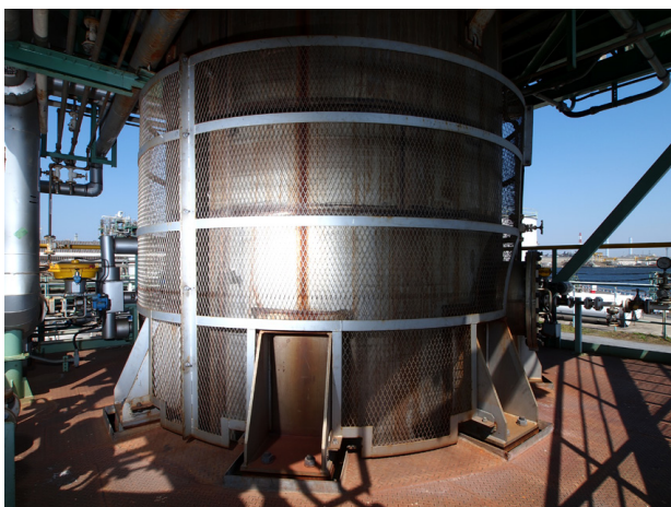
Hastelloy（ネットの内側）で覆われた燃焼炉
