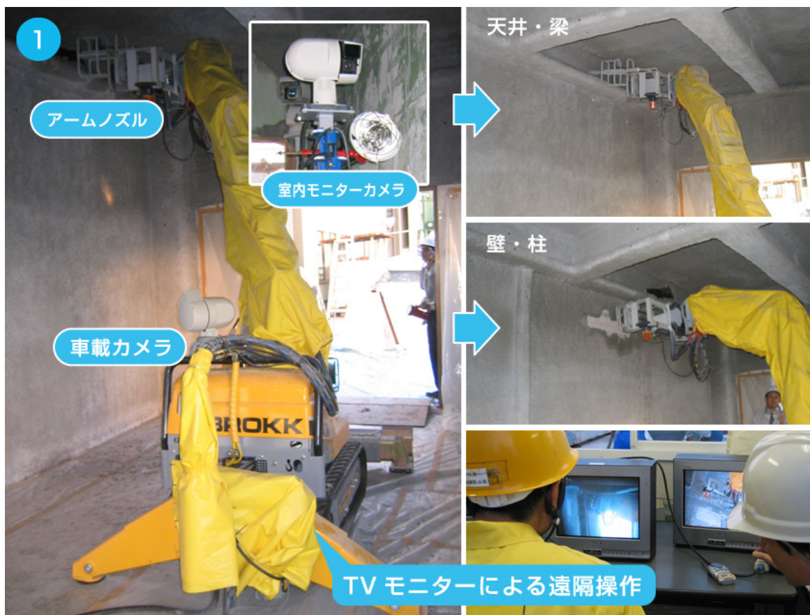
実証実験の様子（模擬アスベストの剥離と除去）
