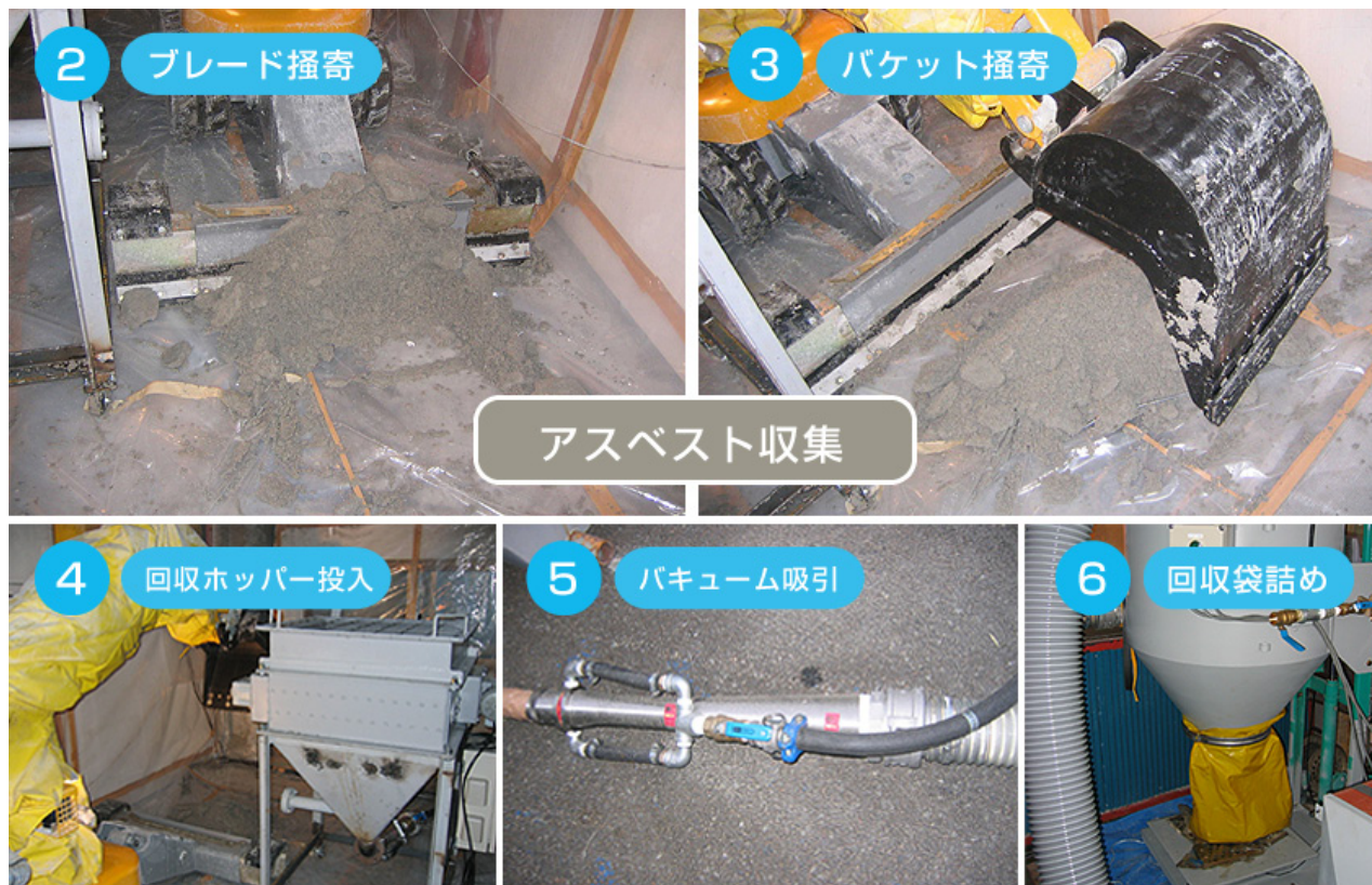
実証実験の様子（除去した模擬アスベストの収集と回収）
