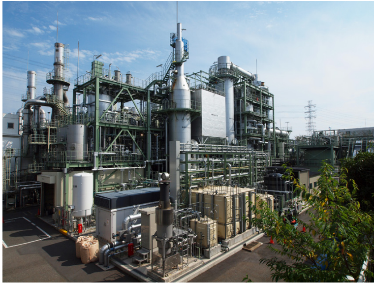
東京都下水道局清瀬水再生センターに設置された下水汚泥ガス化発電システム
