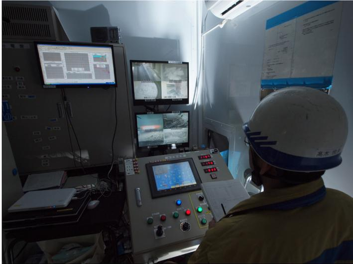
トレーラー内の制御室。作業員はアスベストの飛散や吸い込みを心配することなく、安心して作業ができる
