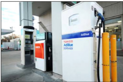
ガソリンスタンドに軽油給油機と並んで設置された尿素水（製品名AdBlue）供給機（右）
